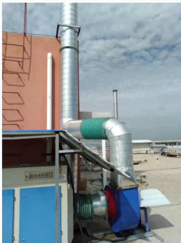
热定型工序集气罩
