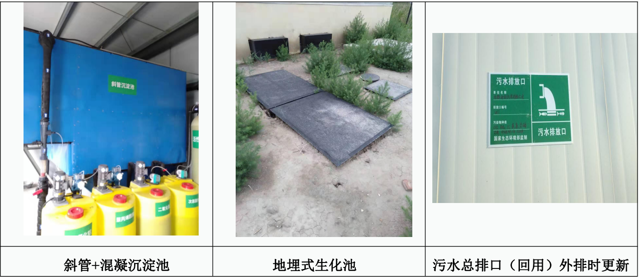
图 4 污水处理工艺及总排口
