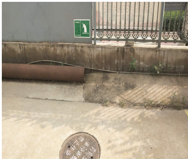
废水排放口标牌
