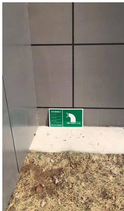
废水排放口标牌
