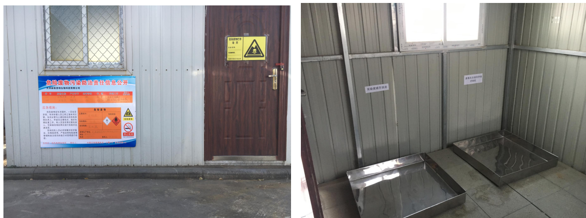
图 2.4-5 现有工程危废暂存间图
